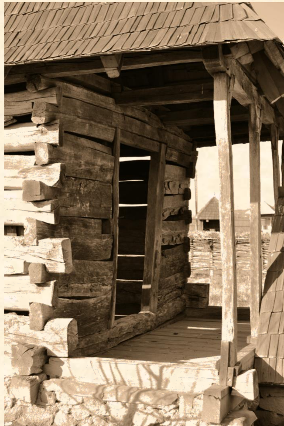
Cămară pe beci. Detaliu îmbinări
