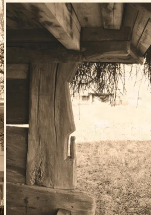
Detaliu stâlp lateral, cu îmbinare în căței. Extremitatea cosoroabei lucrată în motivul cap de cal .
