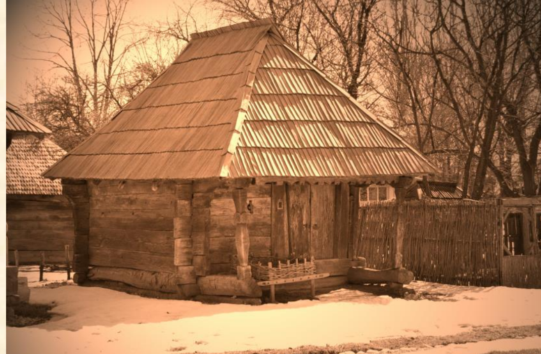
Pimniță – Ploștina, Motru, datată 1794. Construită din bârne de stejar, are prispă joasă la fațadă, cosoroabe și doi stâlpi masivi sculptați, fixați în tălpile laterale; acoperișul din șindrilă este în patru ape.
