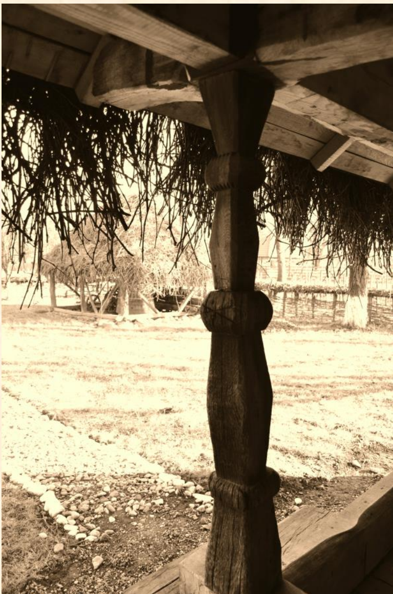
Detaliu pimniță. Stâlpul de susținere a sălii, sculptat cu forme tronconice, separate de noduri decorate cu dinți de ferăstrău .
