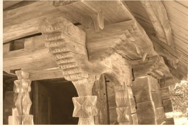
Detaliu elemente arhitecturale (grinzi de steașină îmbinate la jumătate lemn sau suprapuse, prinse în cepi; stâlpi cu capiteluri lucrate în motive geometrice).
