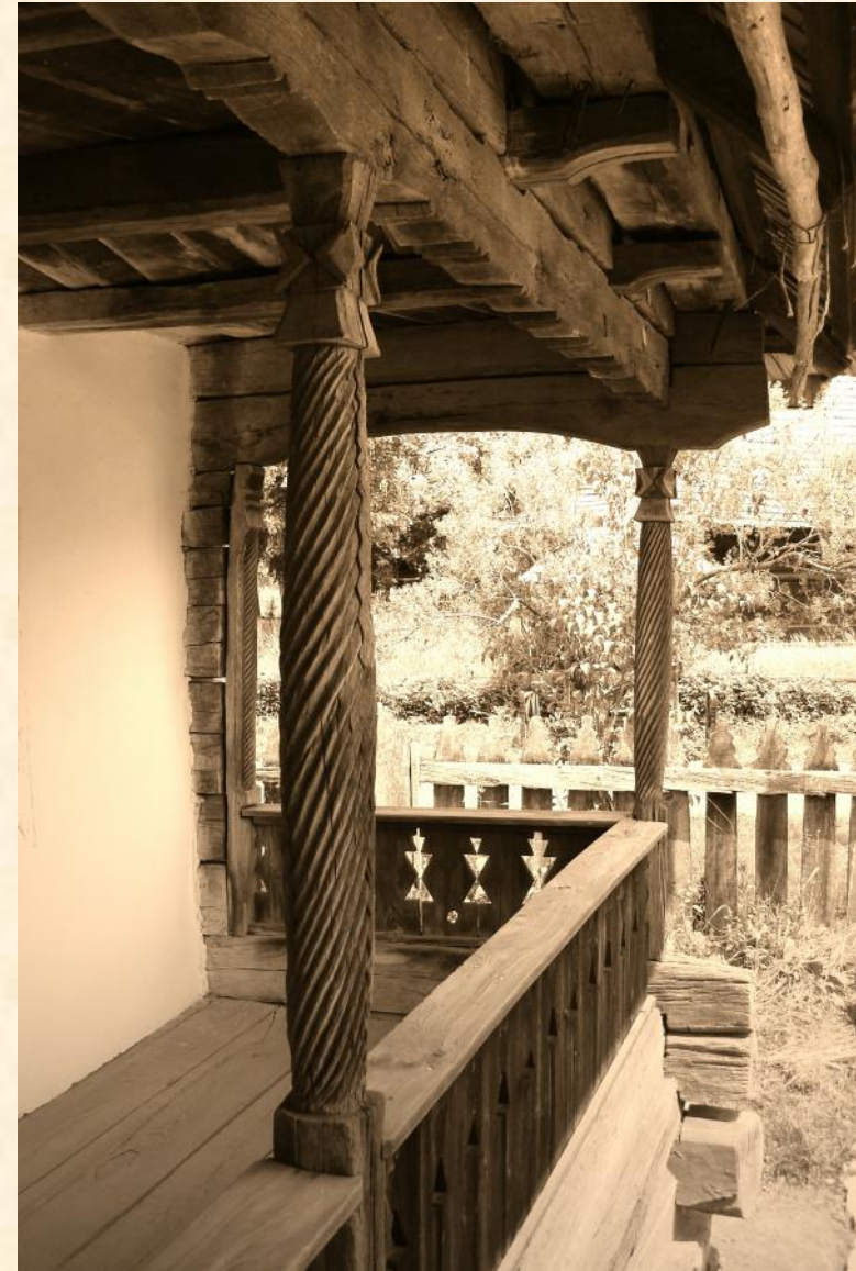
Detaliu prispă - stâlpii lucrați în torsadă și grinzile terminate cu motivul cap de cal . Sub streașină, se poate observa ruda pentru uscatul bucatelor.
