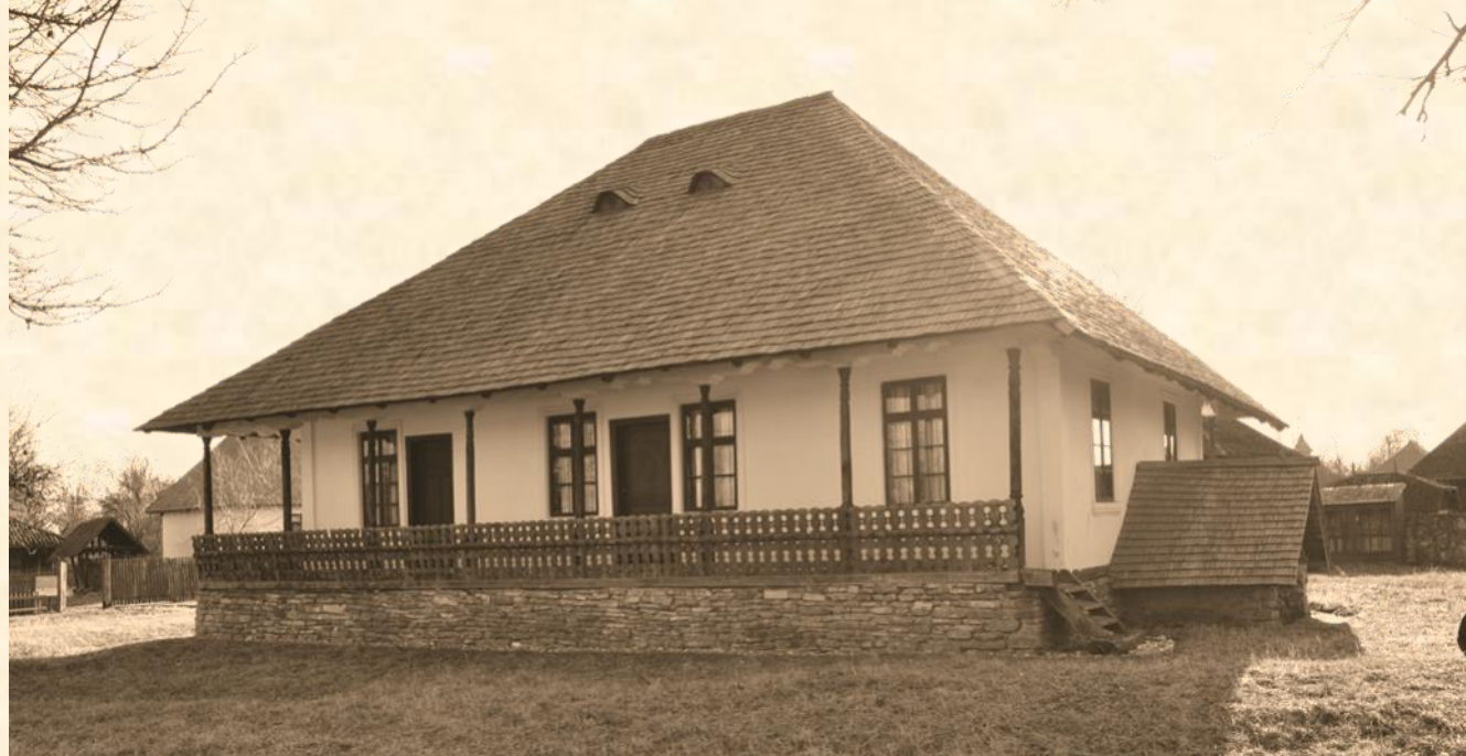
Han de răscruce, fațadă laterală. Se poate observa gârliciul care adăpostește intrarea în beci.
