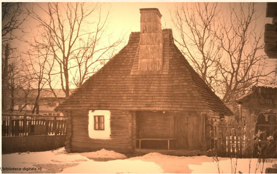
Pimniță – Ploștina, Motru, datată 1794. Construită din bârne de stejar, are prispă joasă la fațadă, cosoroabe și doi stâlpi masivi sculptați, fixați în tălpile laterale; acoperișul din șindrilă este în patru ape.
